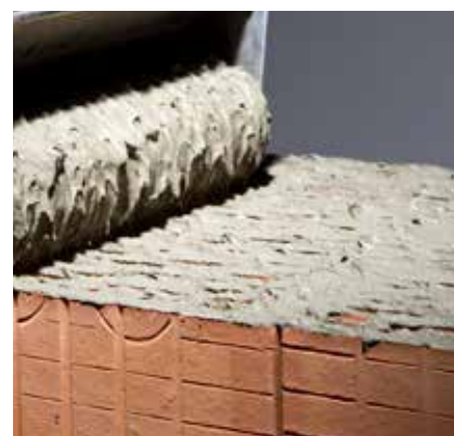
nanášení válcem na žebra cihel
