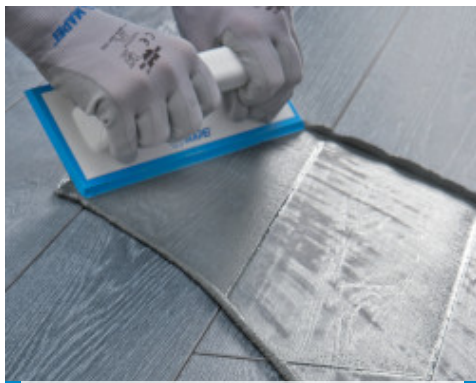
Nanášení Ultracoloru Plus gumovou stěrkou na dlažbu typu gres s efektem dřeva
