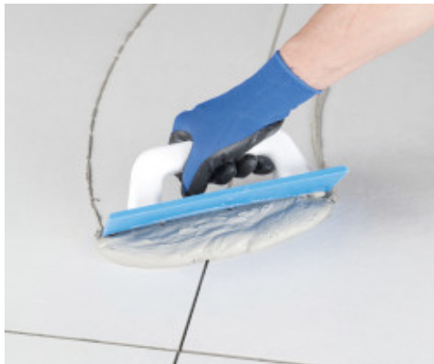
Nanášení Ultracoloru Plus gumovou stěrkou
