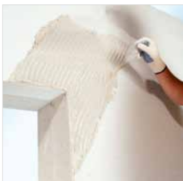
Provádění diagonální výztuže
