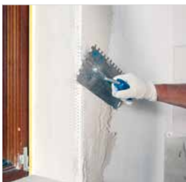
Instalace rohového profilu
