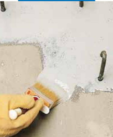
Aplikace Eporipu jako adhezni můstek štětcem
