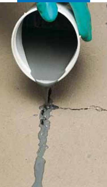
Oprava trhliny v cementovém potěru Eporipem
