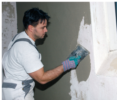
Malta PCI Polycret ® K30 Rapid se snadno aplikuje v tloušťkách od 3 do 30 mm.
