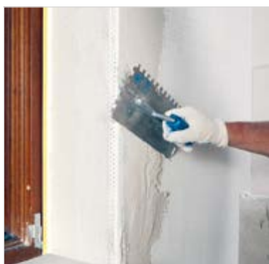
Instalace rohového profilu
