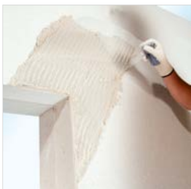
Provádění diagonální výztuže
