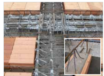
uložení trámečků do železobetonového průvlaku
