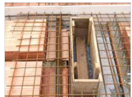
výměna u prostupu stropem pomocí vloženého úhelníku 75/50/6
