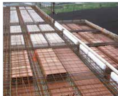
přerušení tepelného mostu mezi balkónem a stropem
