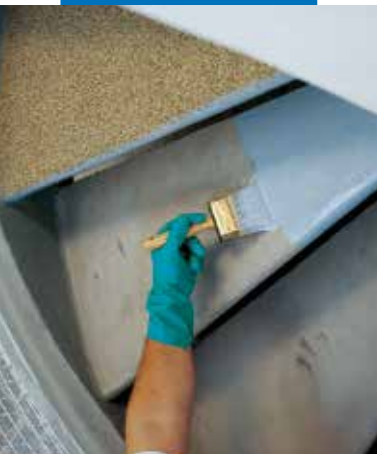
Aplikace první vrstvy Mapecoatu I 24 na beton
