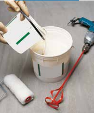
Míchání složky B se složkou A
