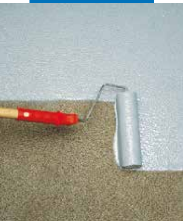
Aplikace Mapecoatu I 24 válečkem
