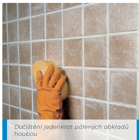
Konečná úprava jedenkrát pálených obkladů houbou Scotch-Brite
