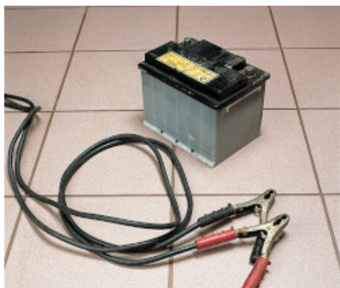
Ukázka spárování v nabíjecí místnosti akumulátorů
