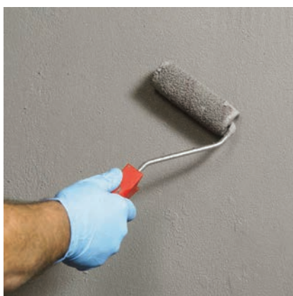
8) První vrstva se nanese např. válečkem celoplošně na podklad.
