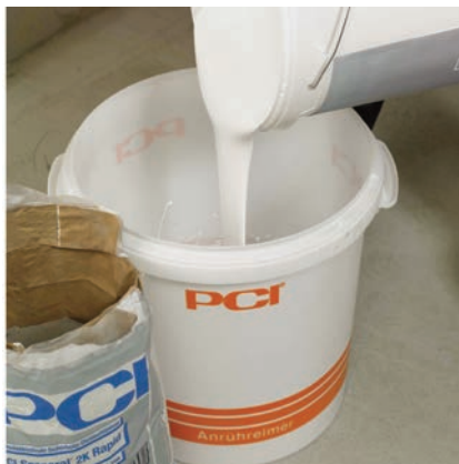
2) Tekutá složka PCI Seccoral® 2K Rapid se nalije do čisté nádoby.
