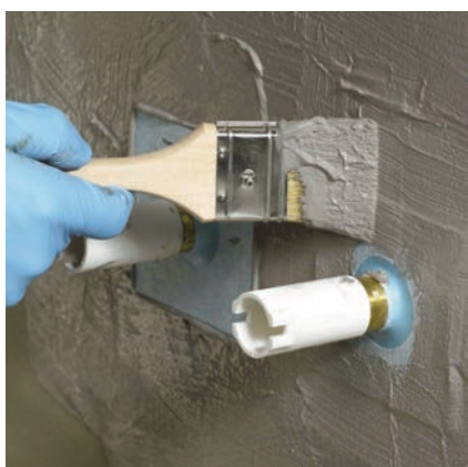
7) Aplikují se těsnící manžety PCI Pecitape® 10x10.
